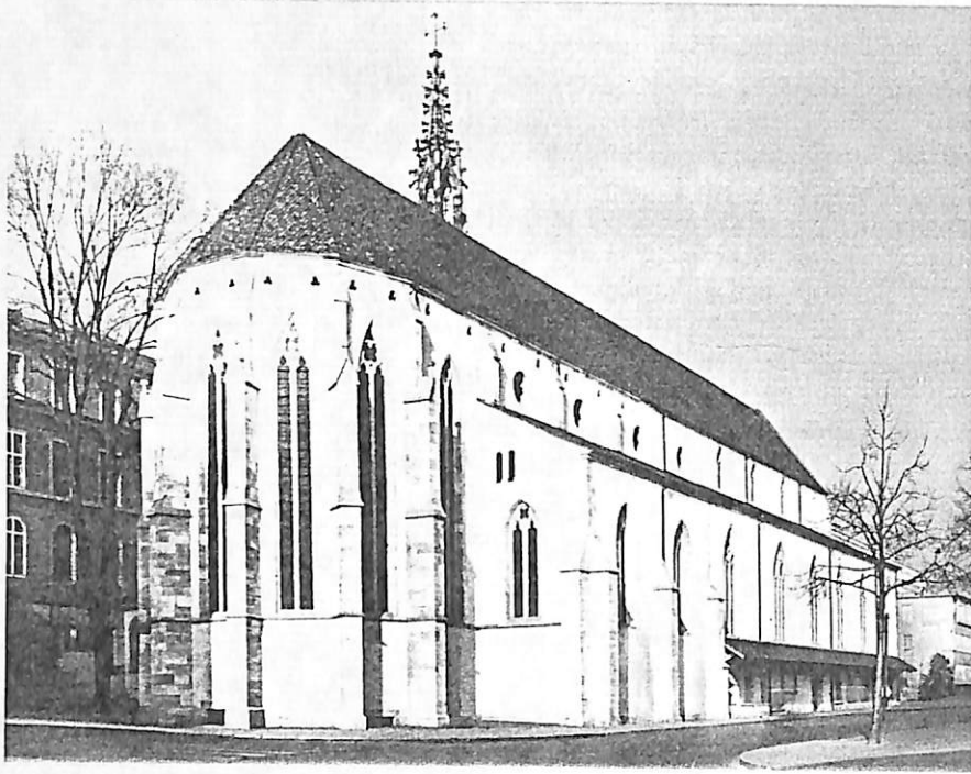
9 Nord- und Ostfassade, kurz nach der Wiederherstellung von 1954.
